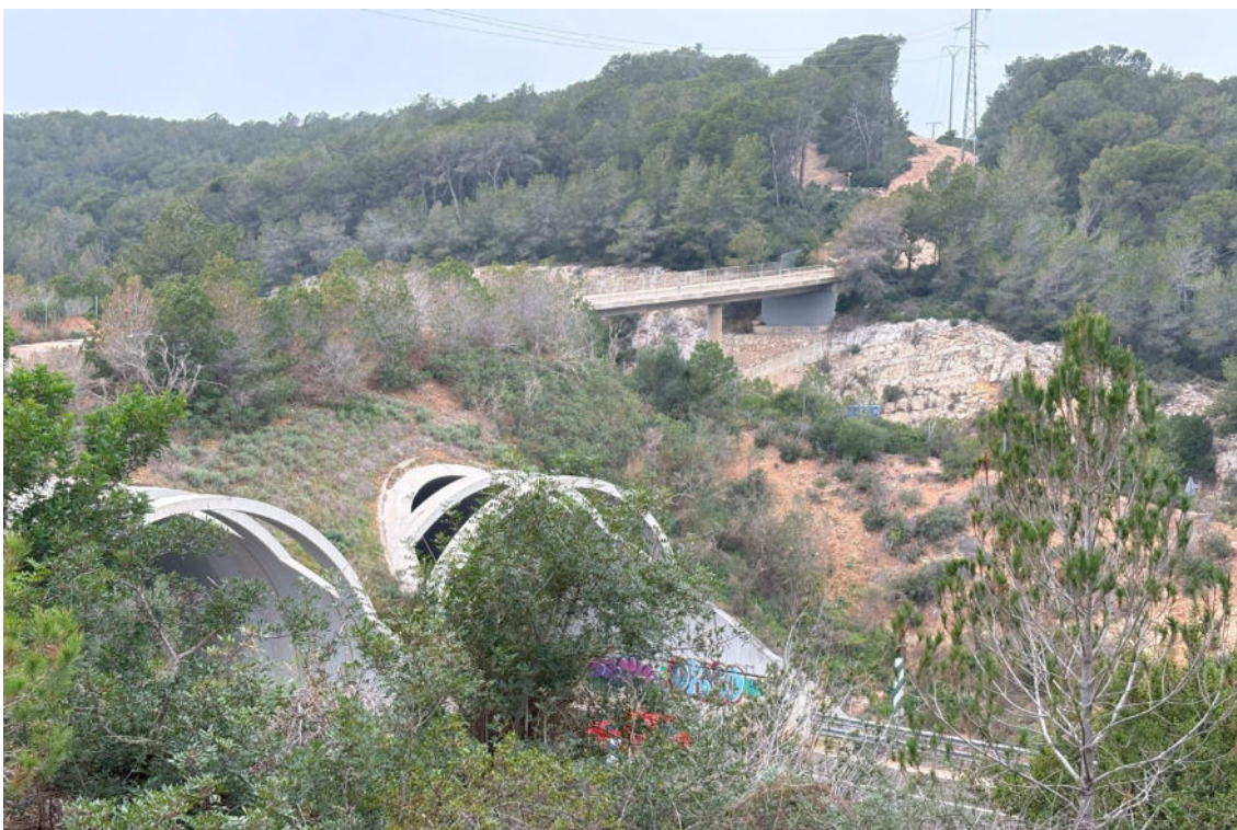
Foto. Vista des de l'est de la zona marcada en groc a dalt. Pas de l'A-7 i l'Ap-7 creuant l'Anella Verda, l'alçada de Boscos de Tarragona. S'observa també línies elèctriques i traces d'infraestructures soterrades. Font: @Caribay Márquez
