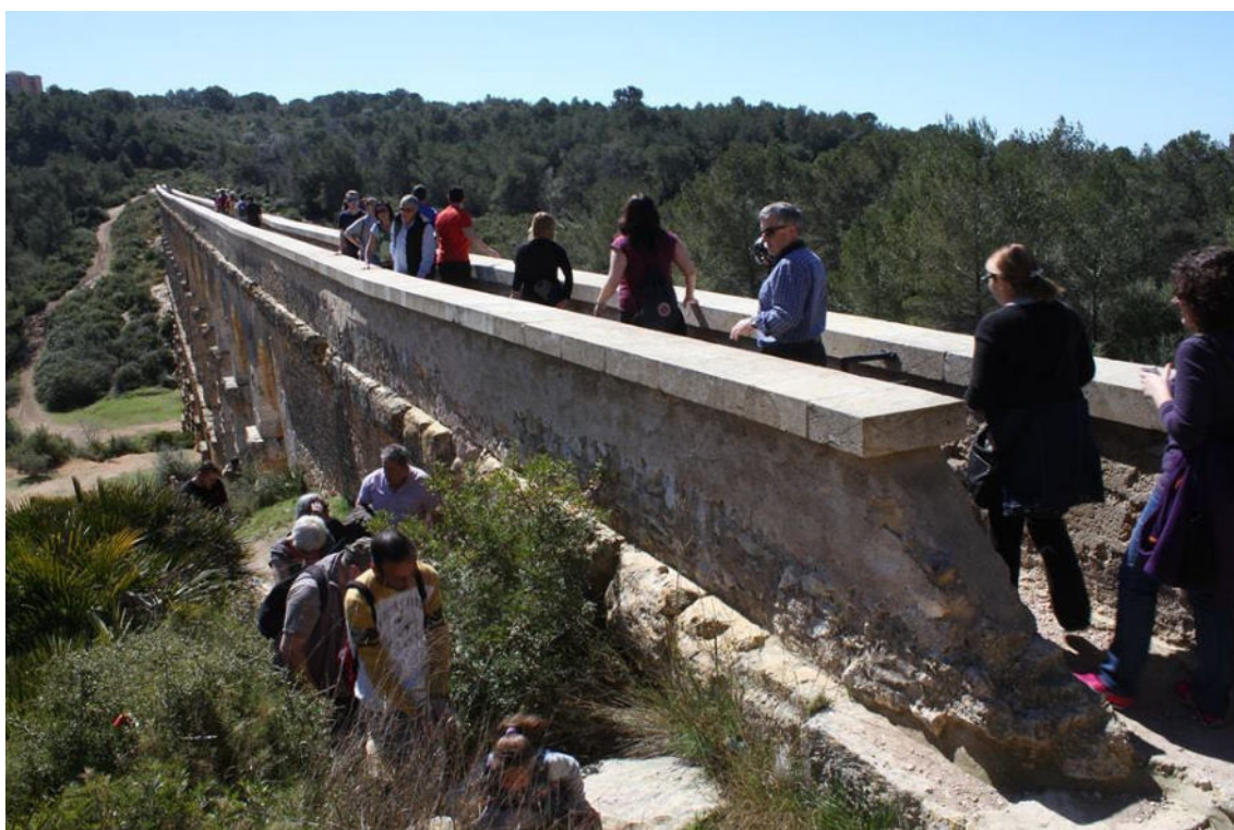
Foto. Gran nombre de visitants a l'aqüeducte de les Ferreres (Pont del Diable). Font: ©Eduardo Soler.
