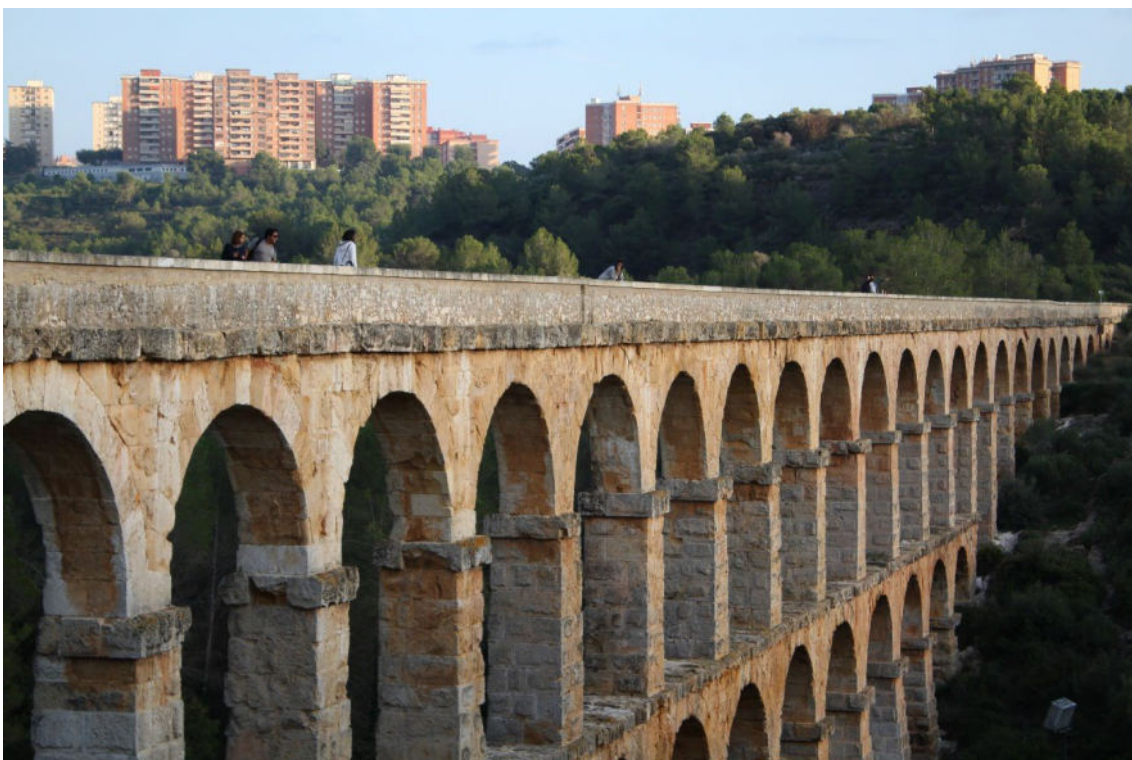
Fotos. El Pont del Diable (Aqüeducte de les Ferreres), situat al límit de les dues unitats, seria l'element més característic del patrimoni romà ubicat a l'Anella Verda de Tarragona. Font: ©Eduardo Soler
