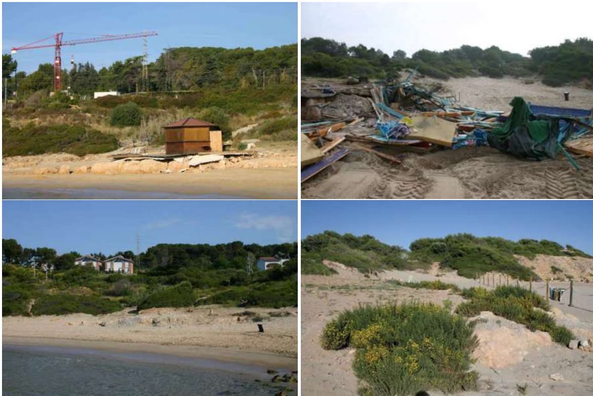
Fotos. Imatge de l'operació de l'eliminació de la guingueta del costat de llevant de la platja de la Savinosa. Dalt, foto de 2004 amb la guingueta en desús, i demolició el 2009. Sota, aspecte el 2009 i posteriorment el 2011 d'aquesta mateixa zona. Font: ©Eduardo Soler
