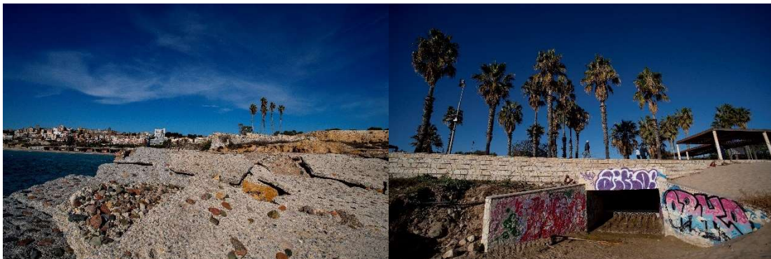
Fotos. Respectivament, restes de plataforma de formigó a la Punta del Miracle i marge del passeig marítim i obra de fàbrica de drenatge a la platja de l'Arrabassada. Font: ©Ferran Aguilar
