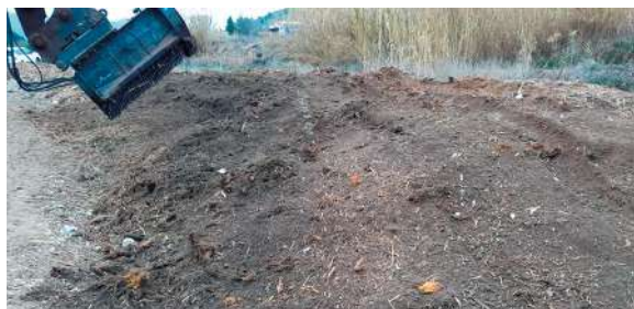
Desbroce mecanizado en formaciones monoespecíficas de caña
