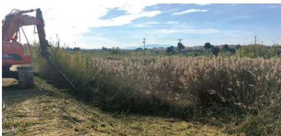
Desbroce mecanizado en formaciones monoespecíficas de caña
