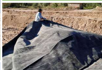
Extensión manual de geotextil
