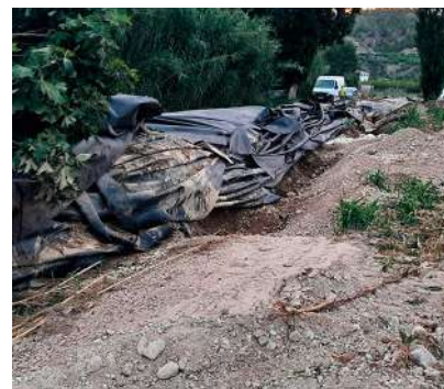
Daños producidos por la DANA de 2019 en zonas de actuación cubiertas con lámina de PEAD
