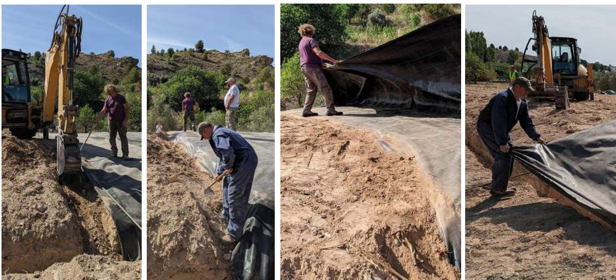
Instalación del primer paño (geotextil)
