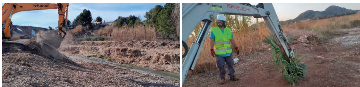
Extracción mecanizada de rizoma
