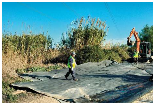
Proceso de retirada de lámina de PEAD
