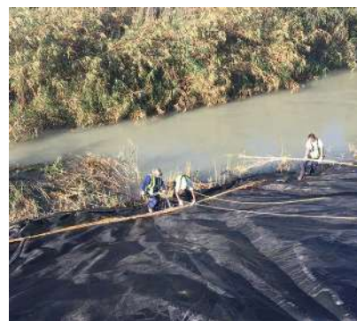
Fijación de la lámina en la parte inferior sin zanja
