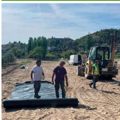
Desenrollado de geotextil
