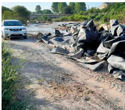
Daños producidos por la DANA de 2019 en zonas de actuación cubiertas con lámina de PEAD
