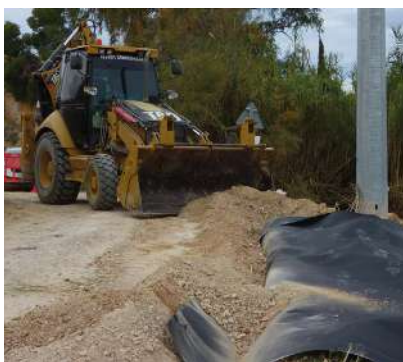
Fijación de la lámina en la parte superior
