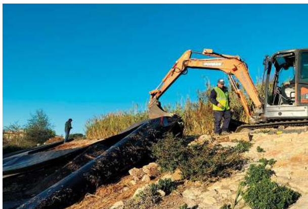
Proceso de retirada de lámina de PEAD
