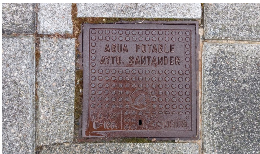
FIGURA R6.1. Registro de red de distribución de agua, Santander.
