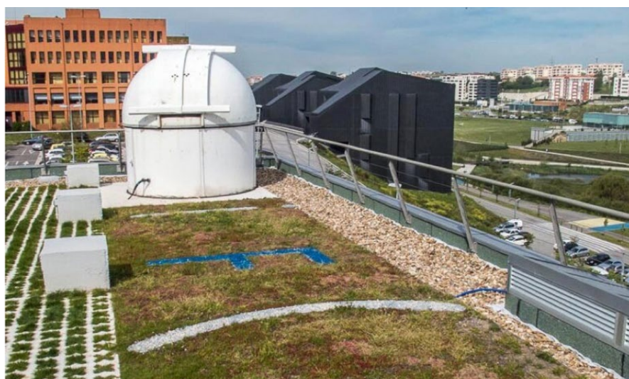
FIGURA R.2.2. Cubierta verde ubicada en el edificio del Instituto de Física de Cantabria
