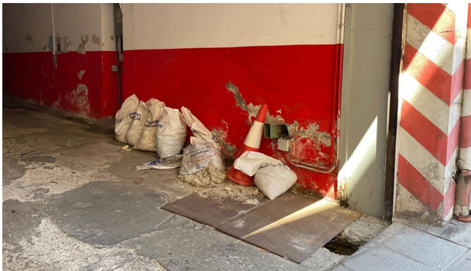
FIGURA R1.7. Presencia de humedades en edificación.
